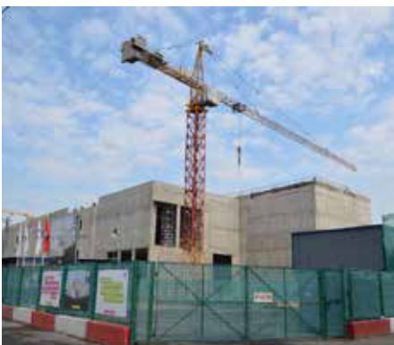
Строительство ПС «Золотареvская»
