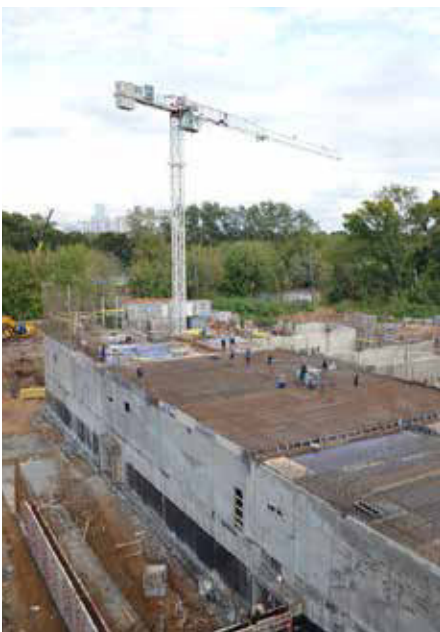
Строительство ПС «Ваганьковская»
