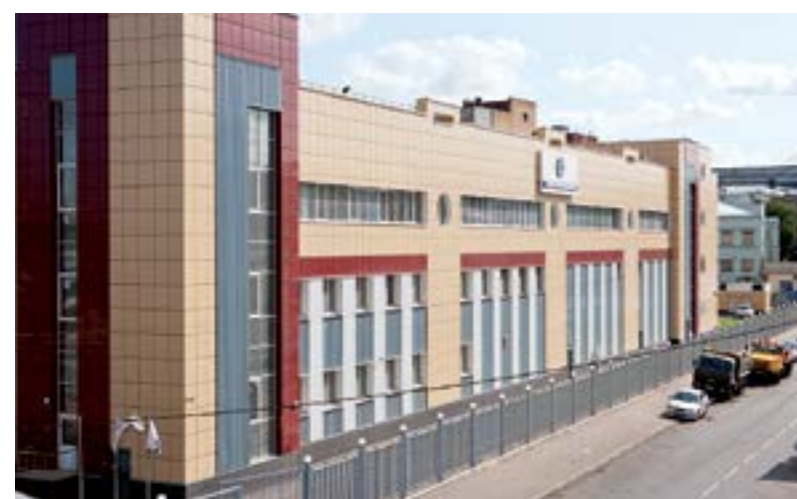
1 ПС «Красносельская» 220/20 кВ мощностью 3 x 100 МВА. Введена в эксплуатацию 17 апреля 2012 года
