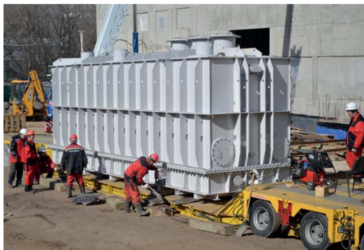
Работы по установке трансформаторов на ПС «Ваганьковская»
