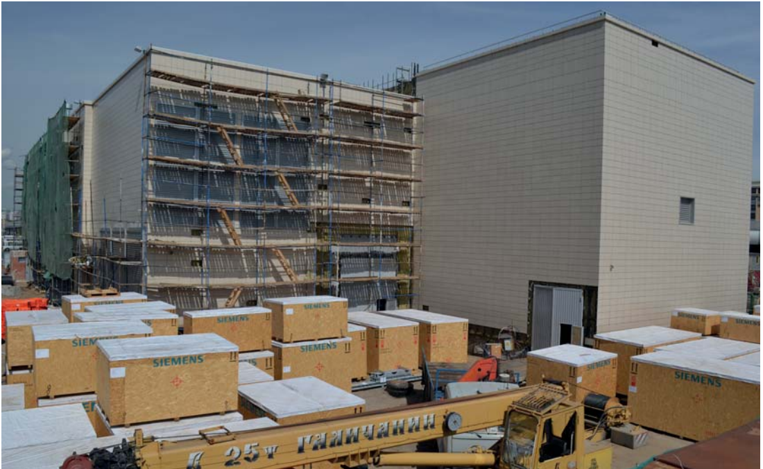
Упакованные части комплектного элегазового распределительного устройства 220 кВ поставлены подрядчиком на ПС «Золотаревская»
